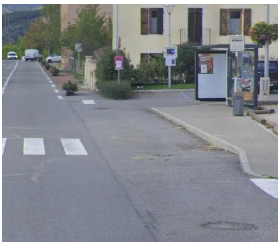
Arrêt de bus en encoche (hors circulation) Source : Google Street View
