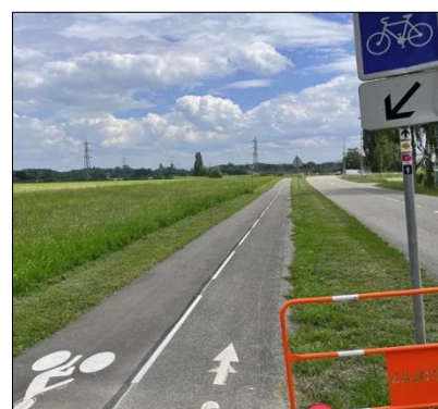
Piste cyclable sécurisée et séparée de la route Source : Google Street View
