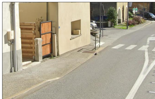
Accès rétabli avec mise en place de bateaux Source : Google Street View
