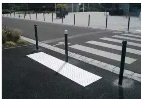
Dalle podotactile avec bordure abaissée Source : CEREMA
