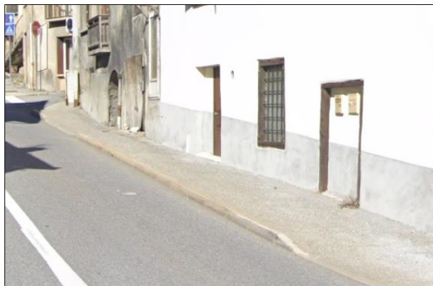
Trottoir surélevé Source : Google Street View
